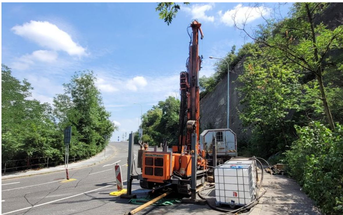
Obr. 4 Realizace průzkumného vrtu J1 v serpentýnách Barrandovské ulice v Praze (červen 2024).
